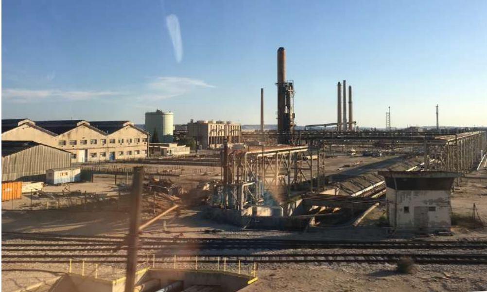
Figure 40 : Une partie du site industriel sur le pourtour de l'Étang de Berre, prise depuis la voie ferrée entre Rognac et Berre-l'Étang (Bouches-du-Rhône), 2019. Crédit photographique : Prost L. (2019)
