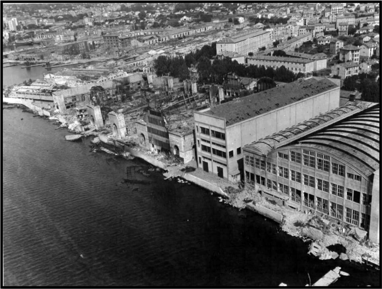
Photographie N°VI. Destruction de l'arsenal du Mourillon en 1944 (Toulon)
