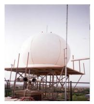
Figure 3 : Radom de radar météorologique de l'aéroport de Niamey.
