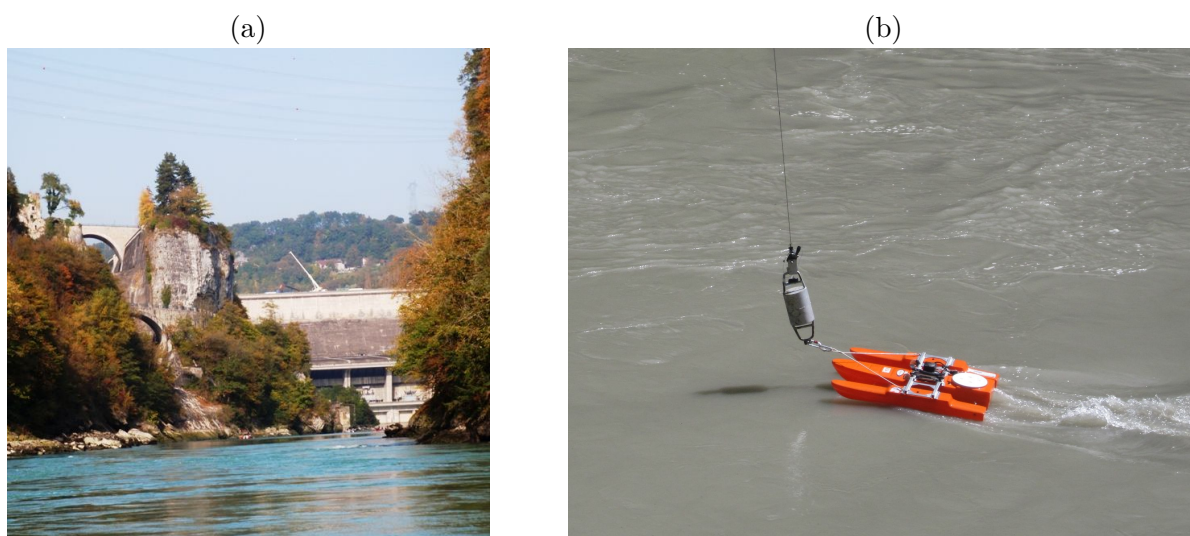
FIGURE 3.18. Barrage de Génissiat vue de l'aval (2010) (a). Mesures ADCP pendant l'APAVÉR en mai 2016 depuis la trille téléphérique de Bognes (b).
