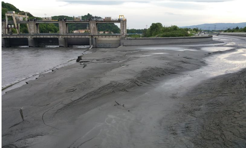
FIGURE 3.24. Dépôts amont au barrage de Beaumont-Monteux en 2015.
