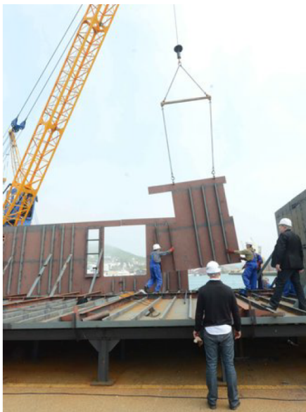
(c) Grue (les travailleurs au sol doivent aider au positionnement précis)
