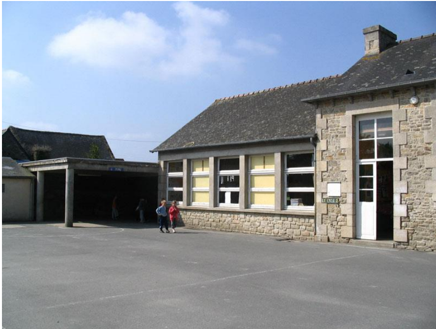
L'école en 2007 avant la rénovation, photo de Didier Pidoux du CAUE 22
