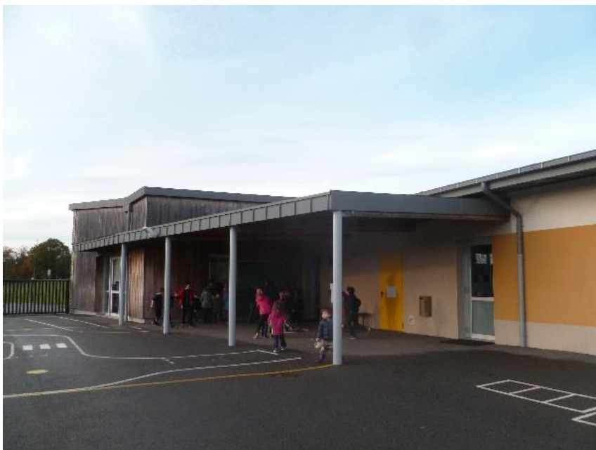
La cour de l'école de St Ganton, 2018, photos de Laurence Lafitte
