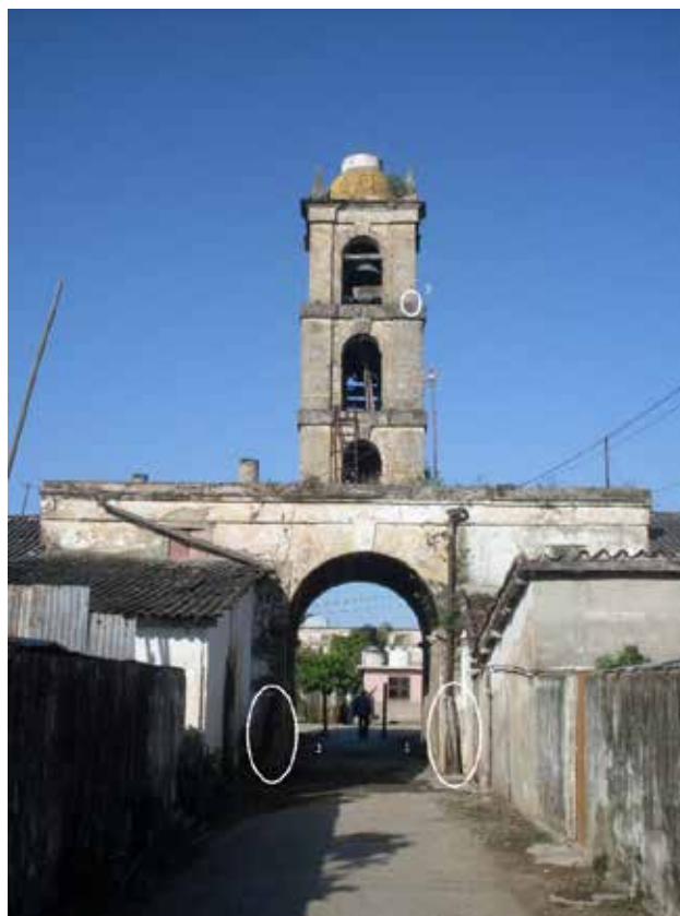
Figure 11. Entrée du baraquement depuis le patio intérieur. 1-poutres de bois qui auraient servi de potence ; 2-anneau métallique qui aurait servi à pendre Ta Ciriaco. Central Méjico 2013. Maxime Toutain
