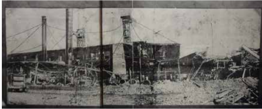
Figure 17. Photographie du central Álava suite à l'explosion du 31 janvier 1915. Auteur inconnu.
