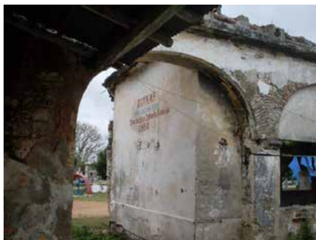
Figure 61. Ruines de la maison de Julián Zulueta. Central Méjico. 2013. Maxime Toutain
