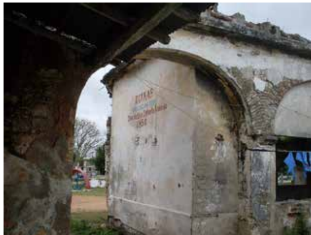
Figure 61. Ruines de la maison de Julián Zulueta. Central Méjico. 2013. Maxime Toutain
