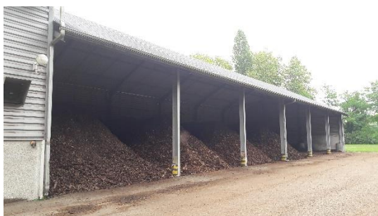
Figure 21 : Hangar semi-ouvert constituant la zone de fermentation des andains : compostière
