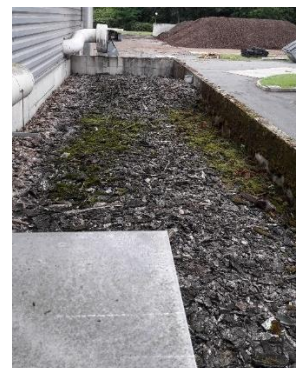
Figure 26 : biofiltre de la compostière
