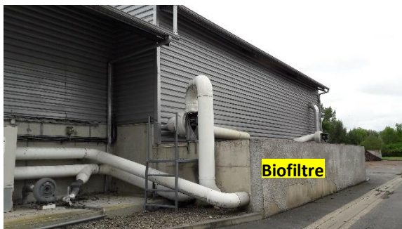
Figure 23 : biofiltre - vue générale
