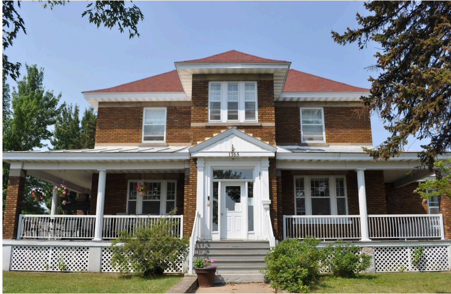
Figure 43. La Maison d'Épique - Photographie façade Est © CD – Centre de ressource Alzheimer
