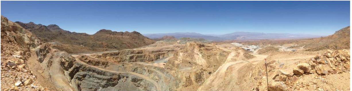
Mine à ciel ouvert de Casposo. Au premier plan, open-pit, où est extraite la roche contenant or et argent. Au second plan, on distingue, dans le prolongement du site d'extraction, les terrils produits par la trituration de la roche. On aperçoit également les infrastructures minières : usine de trituration, lieux de stockage des dorés, réfectoire, poste de santé, bureaux, postes de contrôle.
