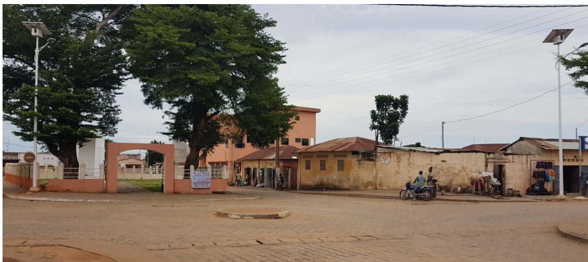
Photo 1 : Deux lampadaires solaires implantés à un grand carrefour de la ville de Ouidah
