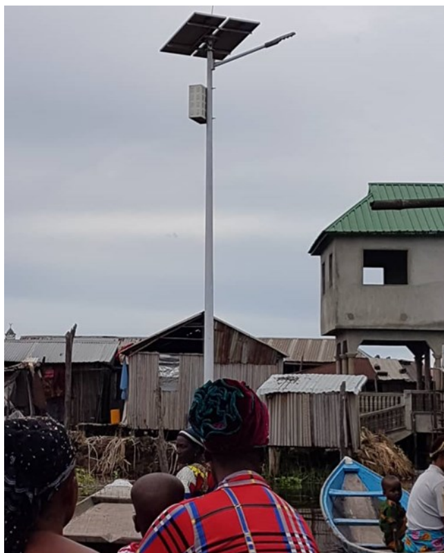
Photo 5 : Lampadaire solaire au cœur de la cité lacustre de Ganvié
