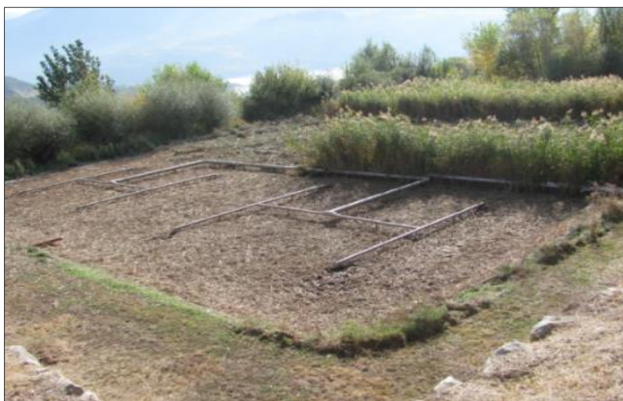
Figure 20. Filtres plantés des roseaux, Saint Sauveur les Charniers, Embrun, France.
