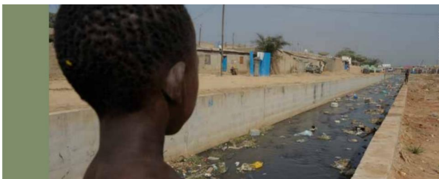
Figure 4. Reconstruction de réseaux d'assainissement en Angola (UNICEF & ADRA, 2016)
