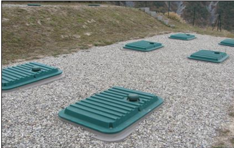
Figure 21. Filtres à substrats de coco aux Crots Montmirail / Embrun, France.
