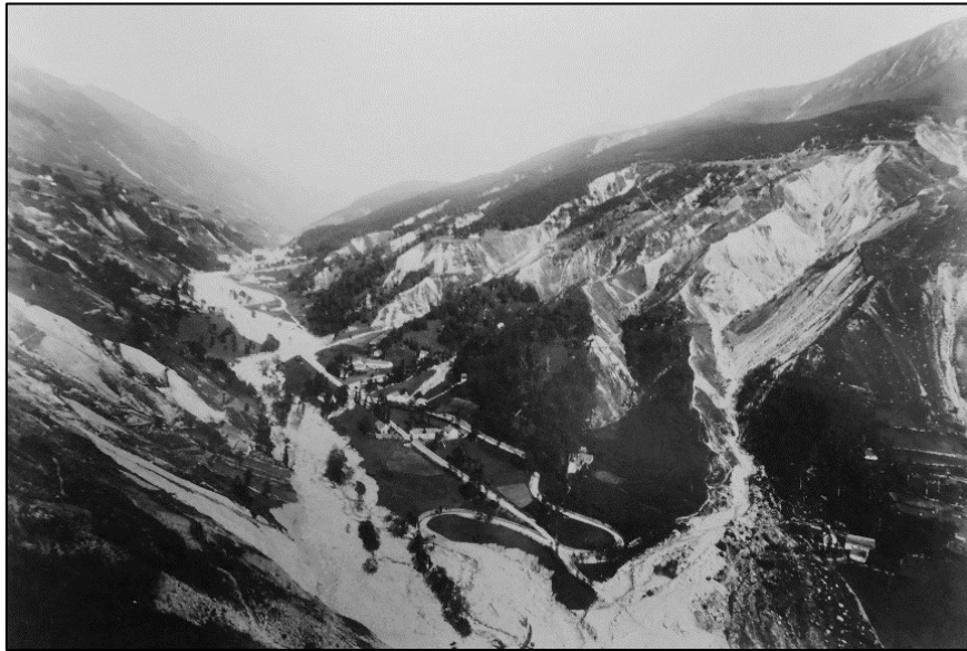
Figure 3.26 : Les ravines de Barèges suite à la crue de 1897 (Fond RTM, AD65).
