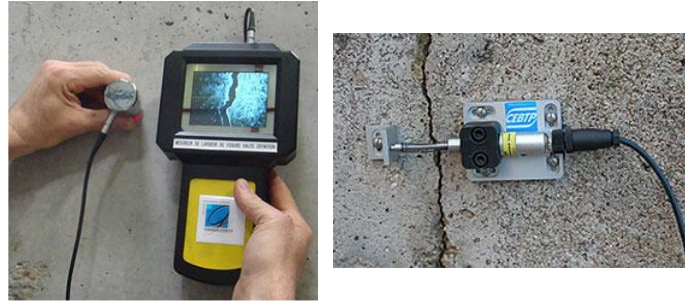
Figure V-1 : [gauche] Exemple de mesure optique de l'ouverture d'une fissure ; [droite] exemple de suivi de l'évolution d'une fissure grâce à un capteur potentiométrique
