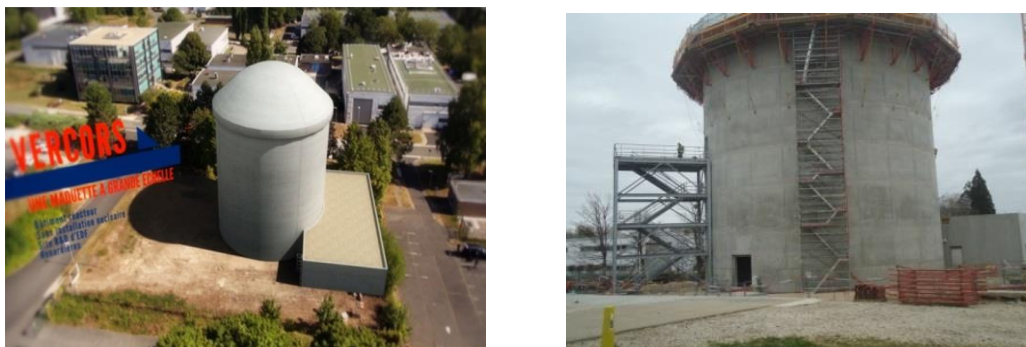
Figure V-4 : Maquette d'une enceinte de confinement développée par EDF: VeRCoRs
