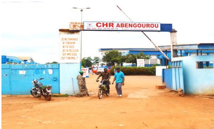
Figure 17 : Aperçu du Centre Hospitalier Régional d’Abengourou
