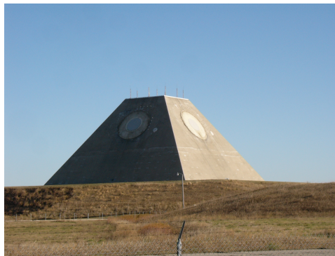
FIGURE 1.20 – Le Missile Site Radar (MSR) a été construit dans un contexte de peur d'une guerre nucléaire. Il contient plus de 5000 éléments et rayonne plus de 200 kW.
