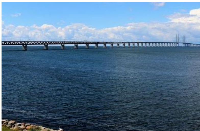
Figure 226 : Le pont de l'Øresund, Source: Guide Michelin
