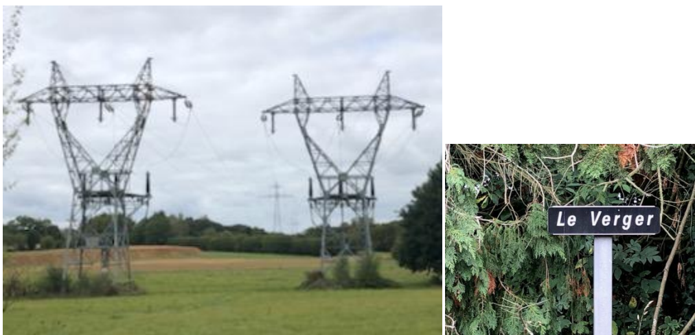
Figure 53 : Vues de pylônes près du lieu dit « Le Verger », (Photographies de l'auteur).
