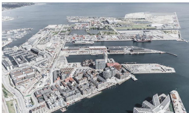
Figure 243 : Nordhavnen (NORDHAVN) et le bâtiment nouveau de l'ONU, Source: Site Urbanlegacylab
