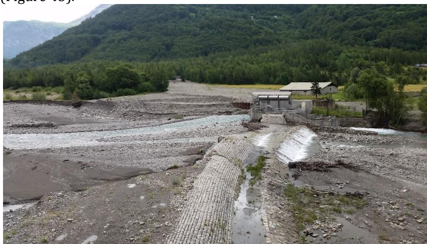
Figure 45 : Dérasement du seuil de la prise d'eau des Ricous sur le Drac (photo : G. Brousse, juillet 2016)
