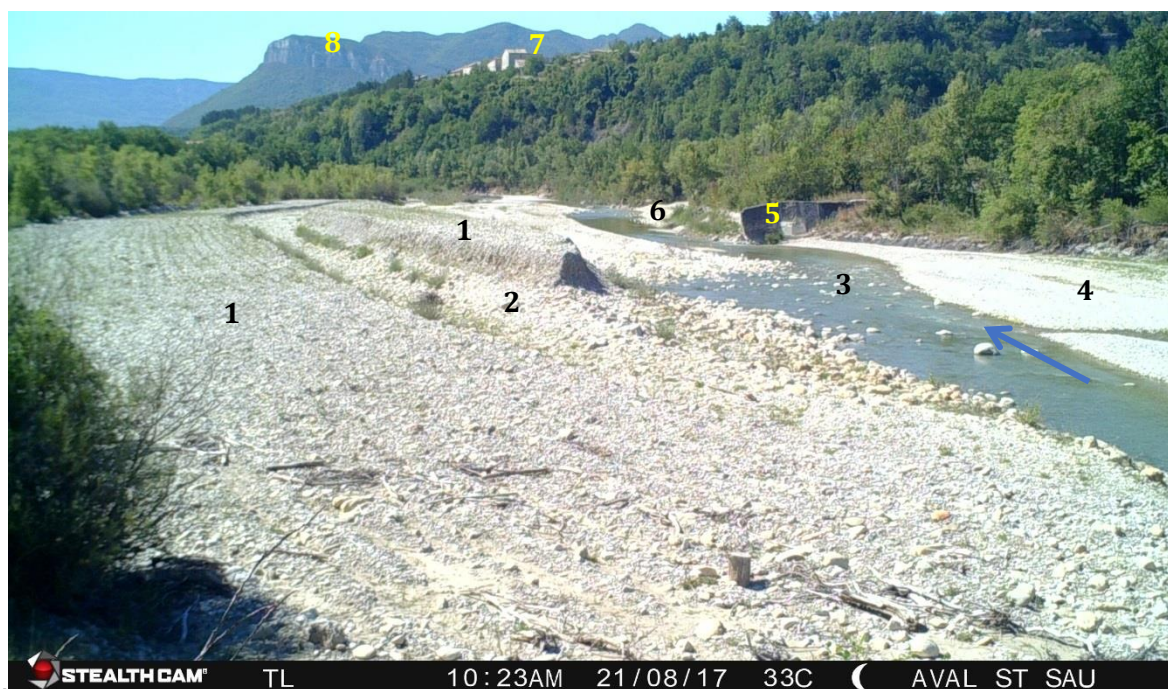
1 : Remblai en rive gauche ; 2 : Chenal secondaire artificiel ; 3 : Chenal principal du Buëch ; 4 : Banc latéral ; 5 : Épi hydraulique ; 6 : Remblai en rive droite ; 7 : Village de Méreuil ; 8 : Crête de la Garde.
