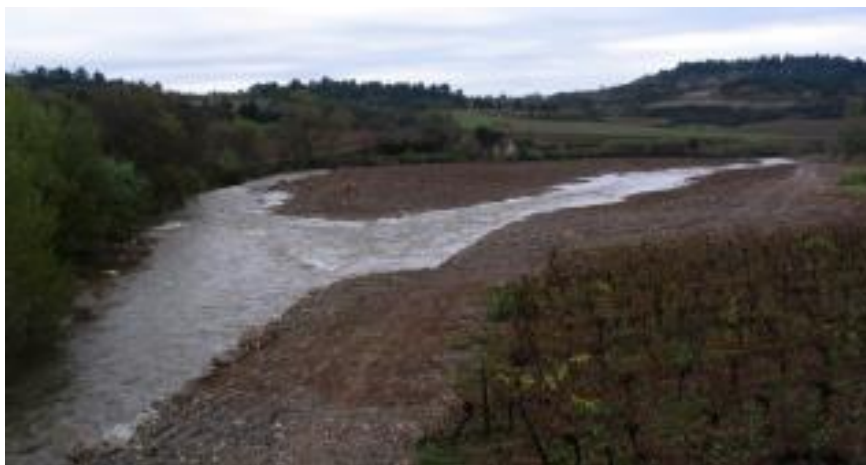
Figure 17 : Suppression des contraintes latérales le long de la Clamoux en aval du pont des Aygadons (photo : Syndicat Mixte Aude Centre, 2005)
