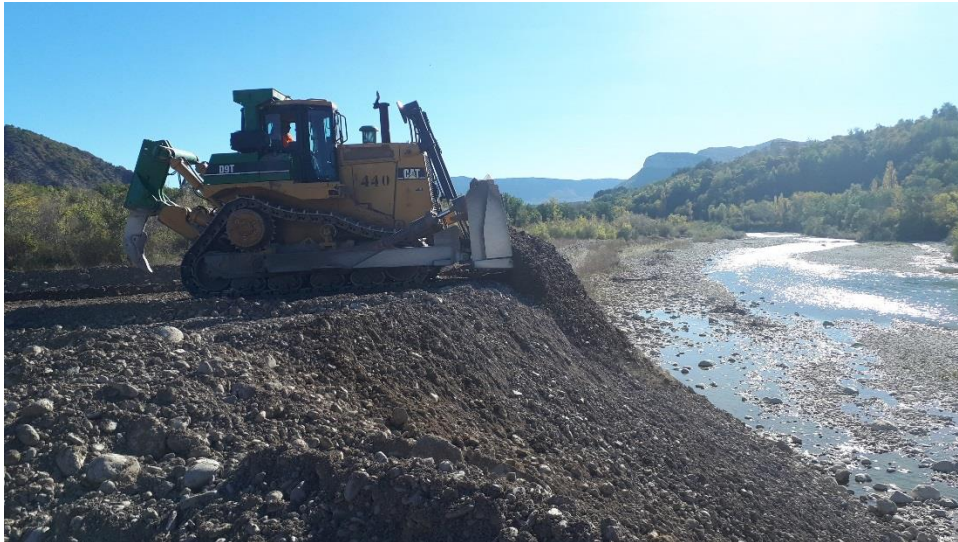
Figure 35 : Remobilisation du stock sédimentaire lors de la deuxième phase des travaux sur le Buëch (photo : EDF, octobre 2018)
