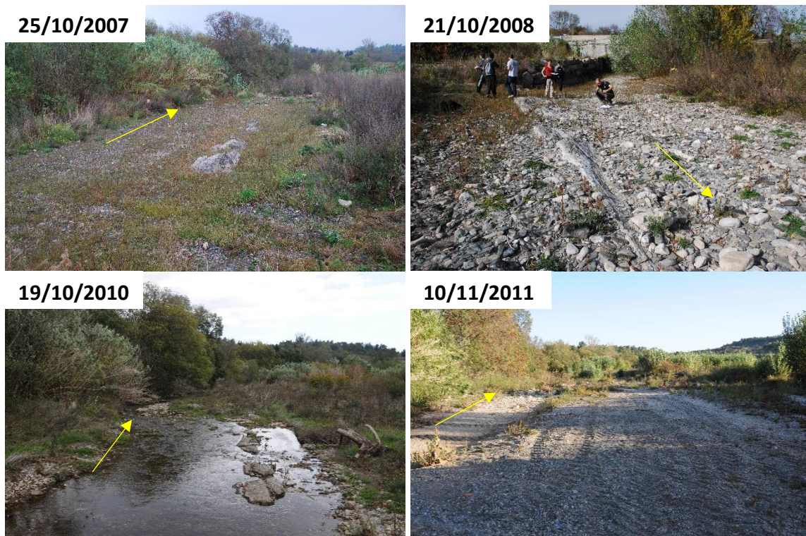
Figure 95 : Chenalisation de la Clamoux en aval du pont des Aygadons (photos : G. Arnaud-Fassetta et M. Fort)
