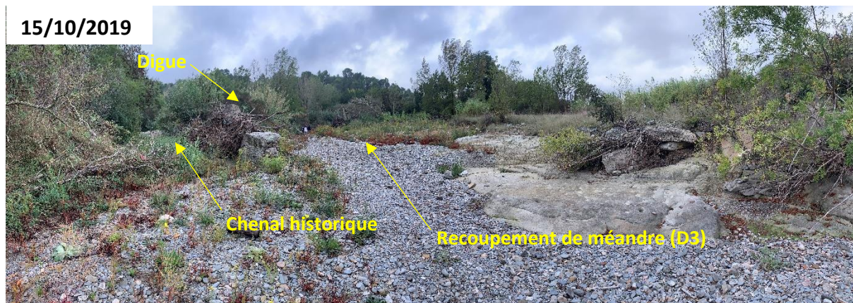
Figure 101 : Destruction du déversoir D3 en aval de la zone restaurée de la Clamoux (photo : G. Arnaud-Fassetta)
