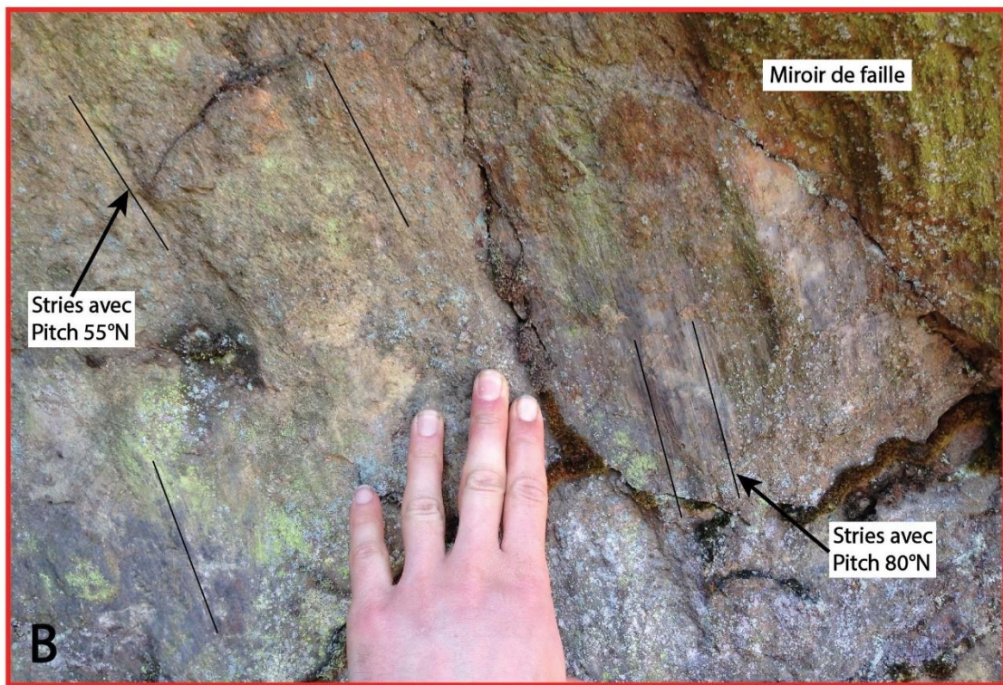
Figure 150 : A) photo de la structure filonienne principale de Pied-Brut qui montre la structuration de la caisse filonienne. B) Détail du miroir de faille de la structure minéralisée montrant des stries à fort pendage vers le nord.
