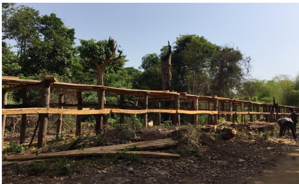
Photo 29 : Réhabilitation du pont de Salifouyah (Maférinyah) suite à l'appui de PREVAC (Photo 1 l'ancien pont Photo 2 le nouveau pont en cours de construction) (Bocar Diawara Ba, avril 2018)
