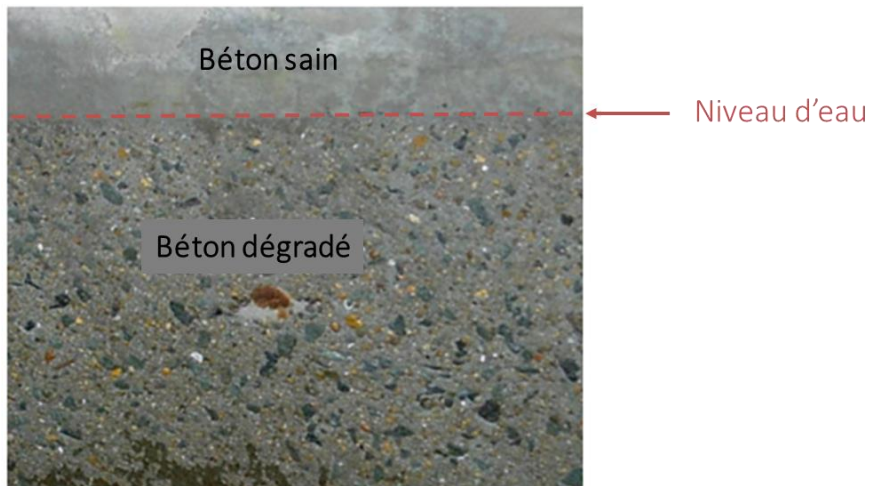
Figure 1. Image de l'intérieur d'un ouvrage de station de traitement d'eau potable, trois ans après la mise en service.
