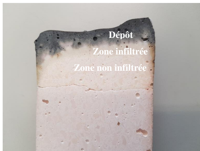
Figure V.2-6 Photographie de la face exposée du matériau Bonite
