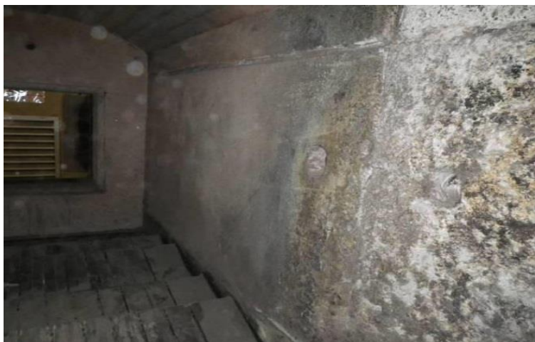
Figure I.3-3 Garnissage réfractaire d'un réacteur de gazéification de taille moyenne (Référence ICARE- journée réfractaire de la commission mixte GFC-SF2M/ MONS 2018)
