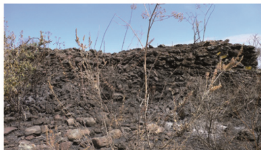
d - Arrière du soubassement pyramidal D7 (vue depuis l'est).
