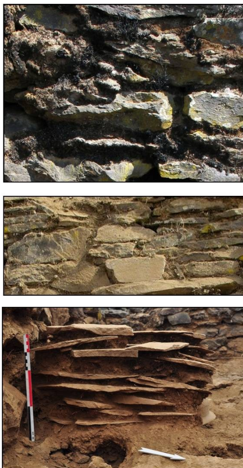
Figure 49 : Trois traitements et appareillages de matériau dur. En haut (a), des modules assez importants peu travaillés et anguleux, au centre (b), un appareillage plus soigné de modules moyens calibrés et facettés, et enfin, en bas (c), un exemple de construction en petites dalles.
