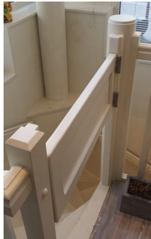
Photo 51: Portillon pour descendre à la remise – 2015 (source : personnelle)
