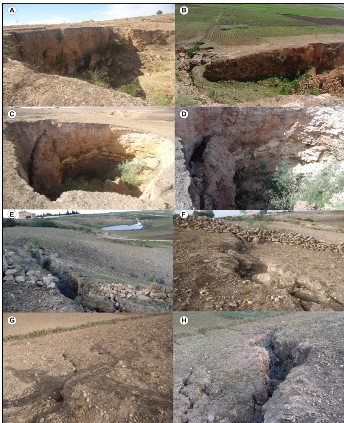
Figure 7.9 - Basculements rocheux des parois des dolines et apparition des fractures circulaires à la surface
