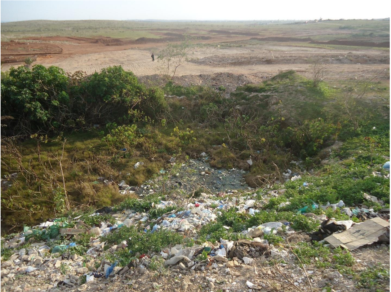
Figure 4.11 – Doline d’effondrement au sud du quartier Djerifat à Safi ( X=32^{\circ}17'02 N, Y=9^{\circ}13'20 O et Z=68 m)
