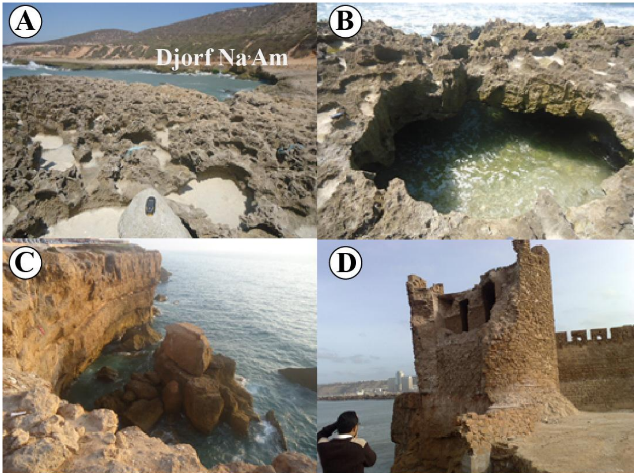
Figure 4.43 – Exemples d’écroulements rocheux entre Djorf Na’Am et Djorf Amouni
