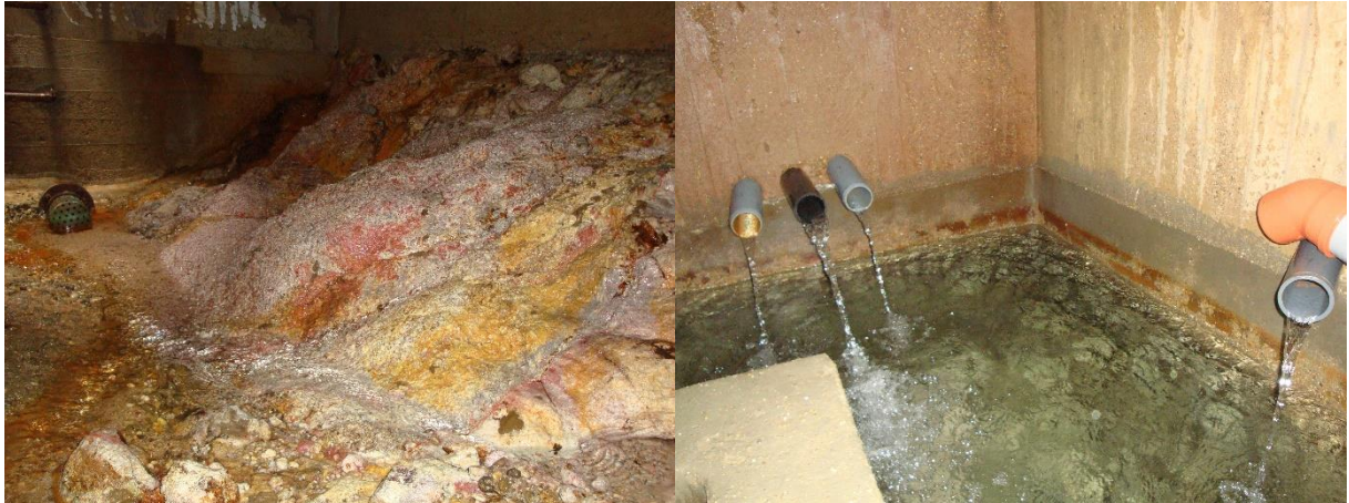
Figure 15: A droite, source Cs1 et à gauche collecteur de sources (dans l'ordre: Cs1, Cs2, Cs3 et Cs4)
