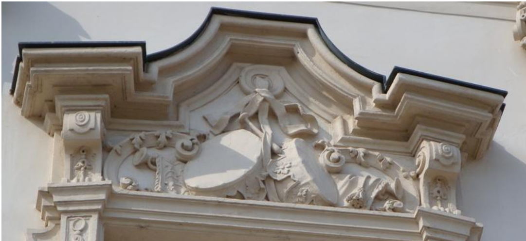
Figure 46 : Fronton de fenêtre du Belvédère 271
