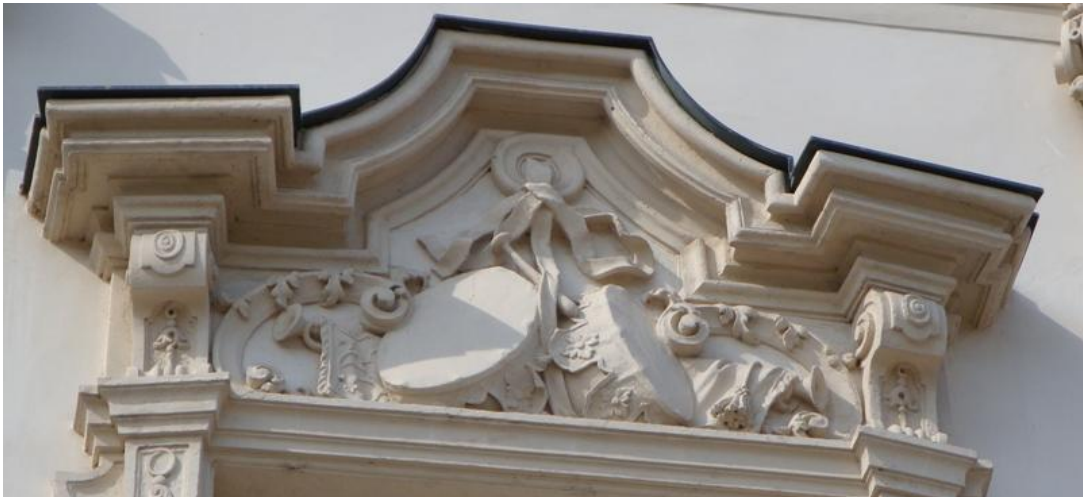
Figure 46 : Fronton de fenêtre du Belvédère 271
