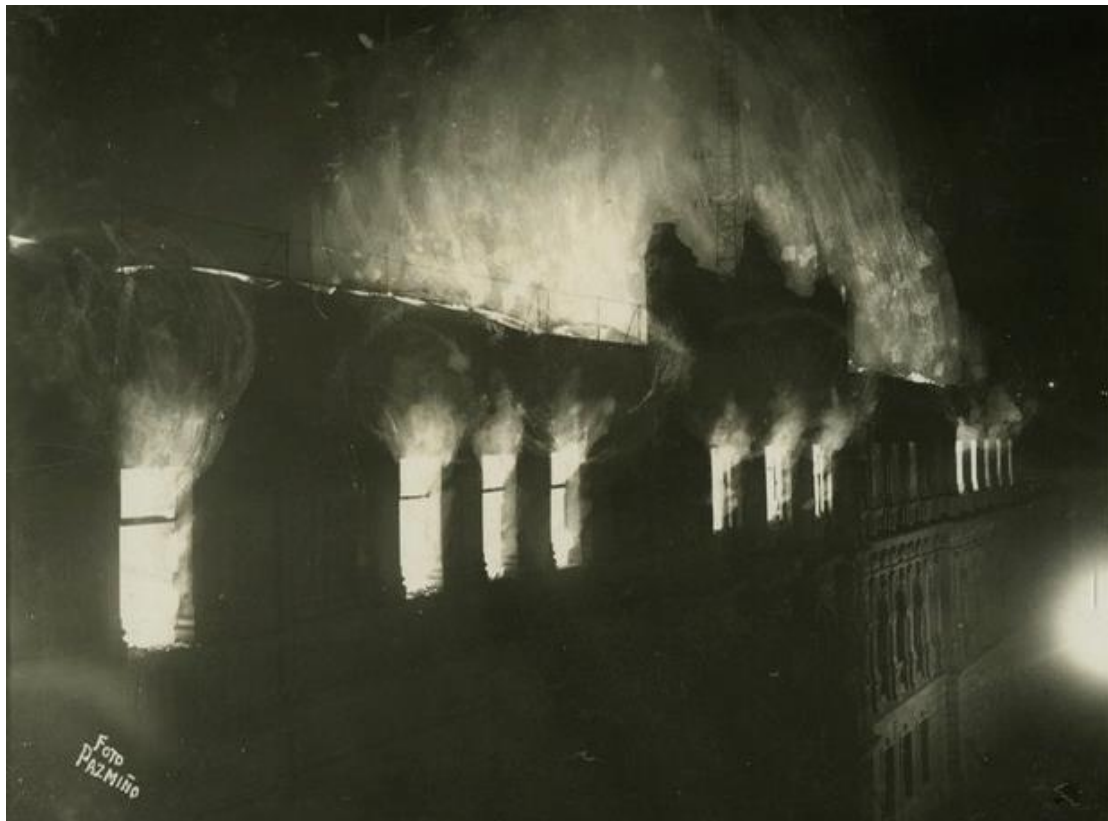
Figure n°19 : Ignacio C. Pazmiño, « Incendio del edificio de la Universidad Central de Quito », épreuve gélatino-argentique, 1929. Institut national du Patrimoine culturel, Quito.
