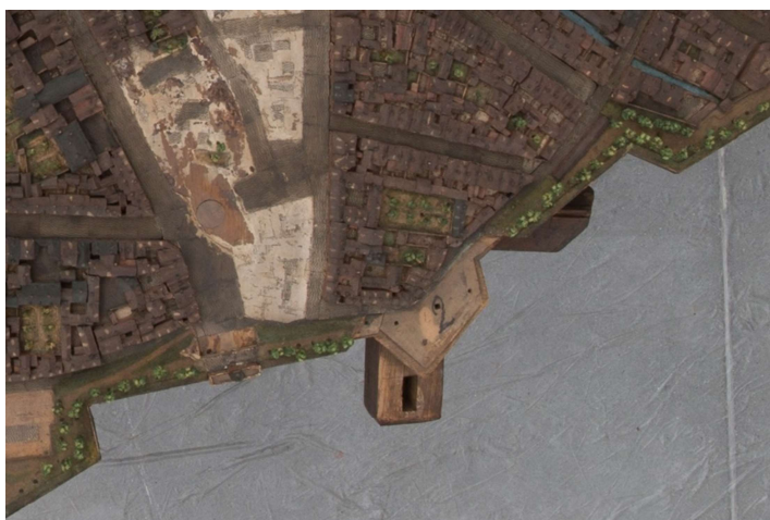
Figure 87 Vue sur la structure en dessous du bastion du Molinel (41) où apparaît le demi-bastion (photo de J.-M. Dautel)
