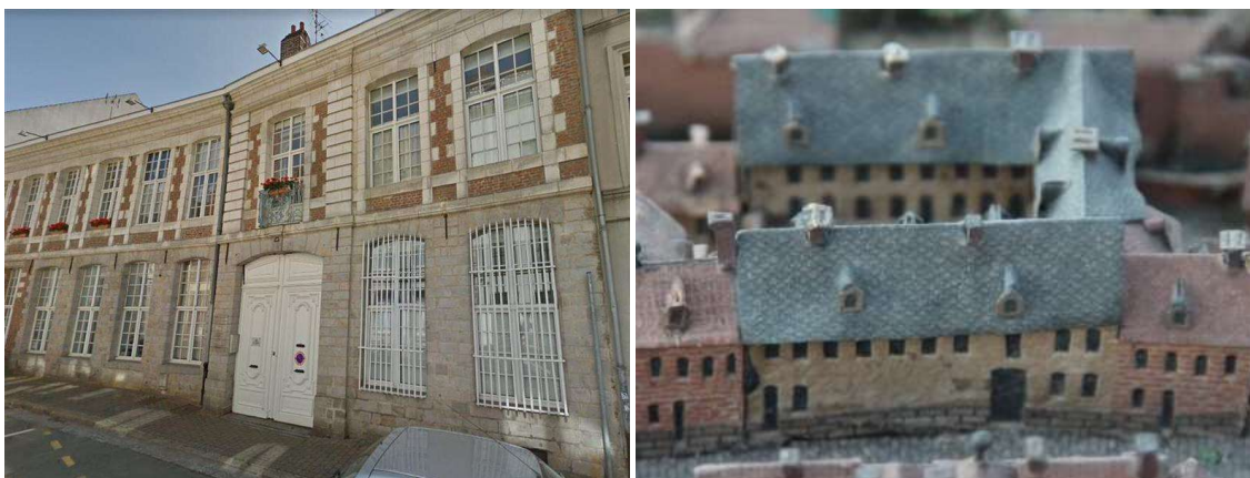
Figure 123 Exemple f8D48 (20 rue des Tours), le remplage en brique n'a pas été retenu pour le papier de façade sur le plan-relief
