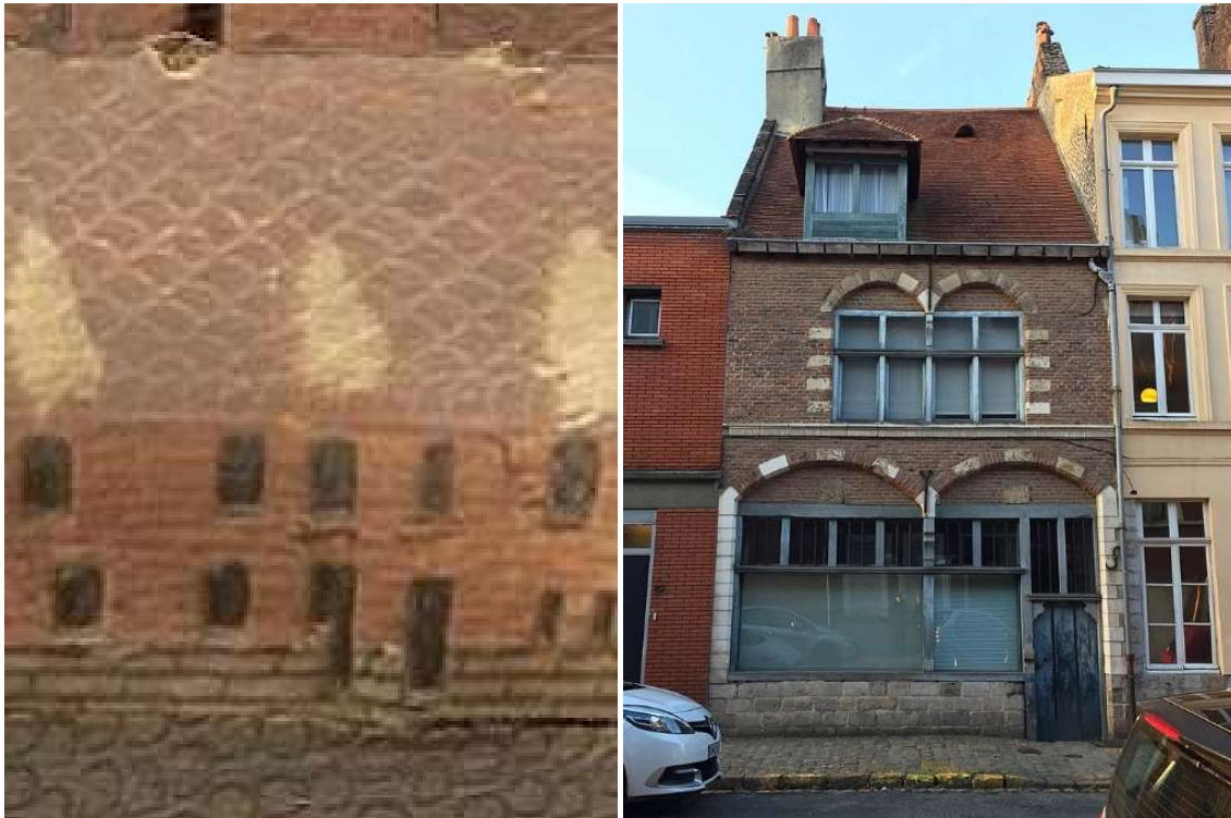
Figure 119 Exemple de f27C53 où la différence de largeur des baies et leur positionnement sur la façade ne sont pas rendus sur la maquette. Le Wimbergue, visible à gauche de la toiture n'apparaît pas non plus sur le plan-relief 528
