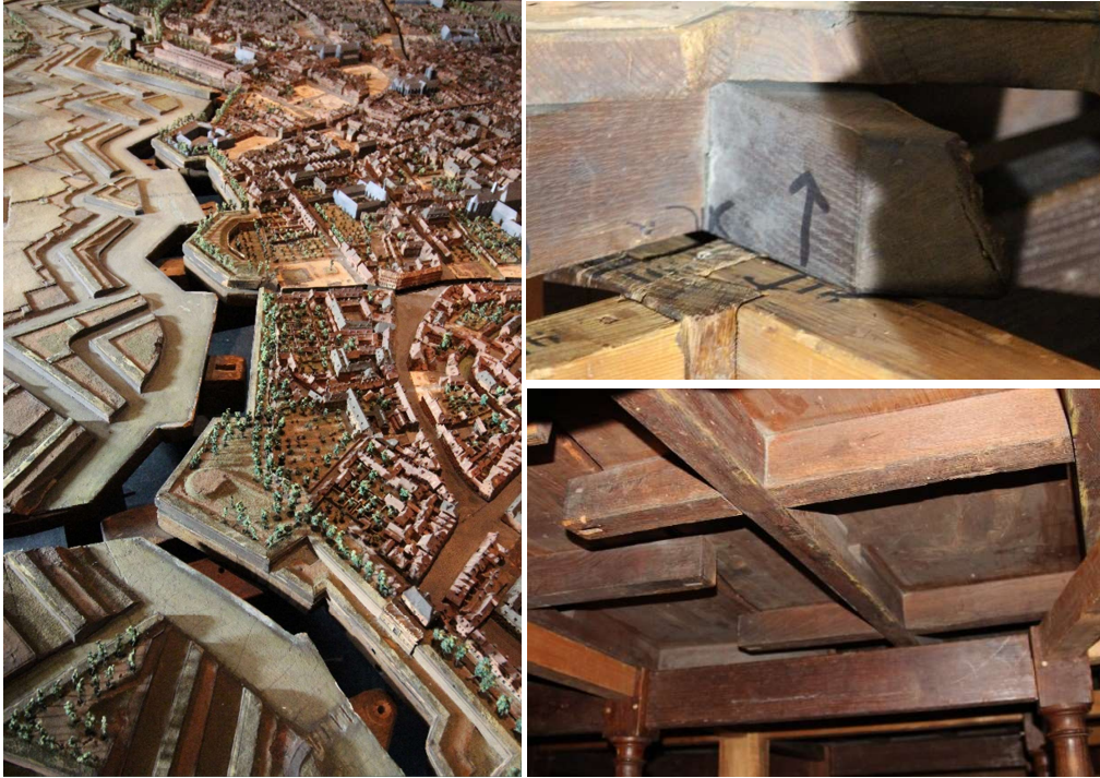
Figure 26 Assemblage des tables, avec repère de la première table et encoches visibles au bout des barres transversales
