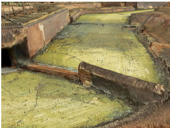
Figure 95 Différence de niveau de part et d'autre du batardeau n° 115 (t3), photo issue du modèle 3d réalisé par on-situ
