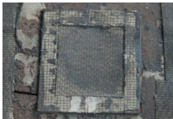
Figure 41 Pavés carrés sous la Bourse
