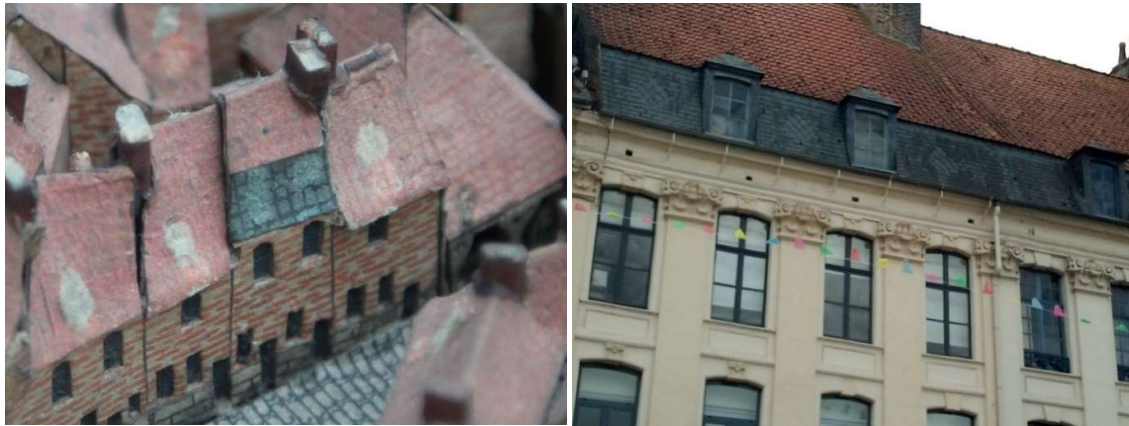
Figure 18 Vue du plan-relief d'Aire-sur-la-Lys et d'une maison de la ville où apparaît l'utilisation conjointe de la tuile et de l'ardoise
