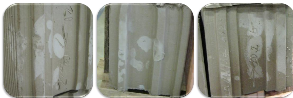
Figure IV.11 : Photographies des briques sèches problématiques présentant des altérations de surface hétérogènes
