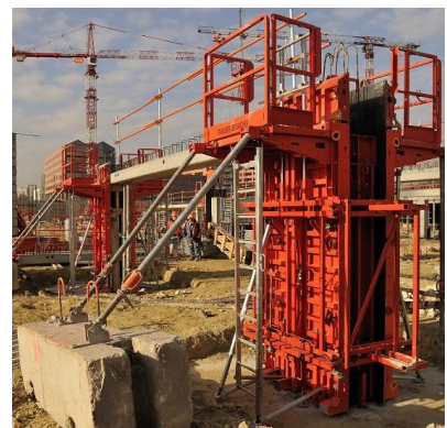
(b) Banche stabilisée par étais
