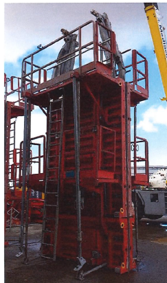
(a) Banche stabilisée par compas
