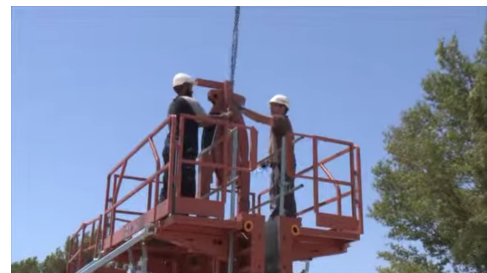
(d) Stabilisation à l'aide du compas
