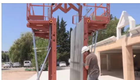
(a) Fermeture du voile à la grue
