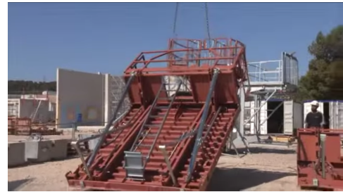
(b) Levage de la banche à la grue
