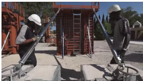
(c) Stabilisation de la première peau coffrante
