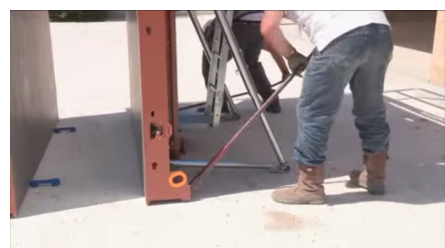
(b) Fermeture du voile à la barre à mine
