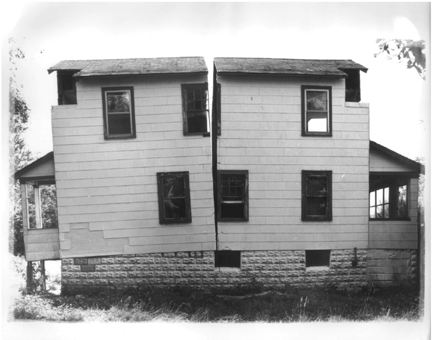
Figure 42 Gordon Matta-Clark, Splitting , 1974, maison coupée en deux.
