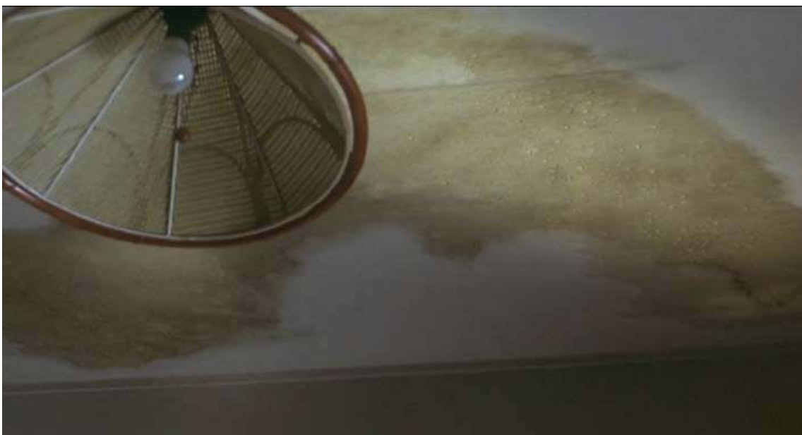
Figure 36 La tache d'humidité qui grandit et qui goutte dans Dark Water (Hideo Nakata, 2002).
