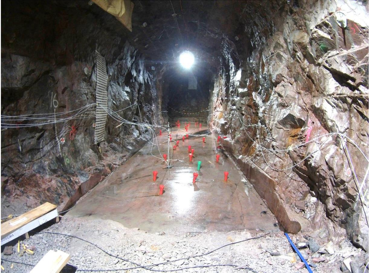
**FIGURE 1-21:** PHOTO PRISE DANS LE TUNNEL D'ÉTUDE (TAS04) APRÈS LE SCIAGE DE LA ZONE DE ROCHE INFLUENCÉE PAR LES FRACTURES INDUITES PAR CREUSEMENT DU TUNNEL. LES CÔNES ROUGES (ET VERT) SONT INSÉRÉS DANS LES 42 FORAGES (ENVIRON 2M DE PROFONDEUR) CREUSÉS POUR L'ÉTUDE DE LA ZDE. CES CÔNES PERMETTENT DE MAINTENIR L'EAU DANS LES FORAGES ET ÉVITER QU'ELLE NE SE RÉPANDE SUR LE PLANCHER DU TUNNEL.
