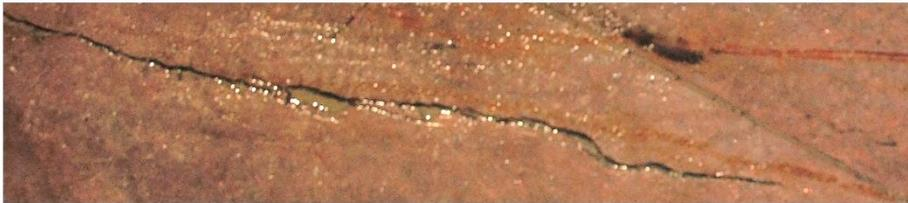
**FIGURE 1-7 :** FRACTURES OBSERVÉES SUR LE TERRAIN (DANS LE TUNNEL « TAS04 », ÄSPÖ HARD ROCK LABORATORY). ELLES SONT CARACTÉRISÉES COMME (A) FERMÉE ET (B) OUVERTE. CES IMAGES MONTRENT UNE PARTIE DES FRACTURES, COUPÉES À 30 CM SUR LA PHOTO.
