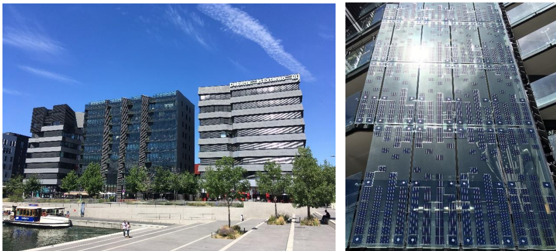
Figure 104 - Îlot à énergie positive Hikari, et façade photovoltaïque d'un des immeubles (HG, 2020).
