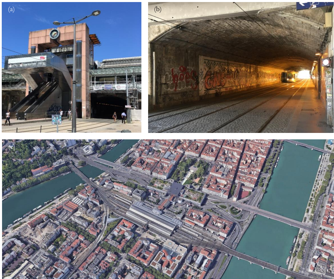
Figure 88 - (a) Entrée sud de la gare Perrache (HG, 2020). (b) Les "voutes" sous la gare (HG, 2020). (c) Vue aérienne de la gare Perrache (Google Earth, 2020).
