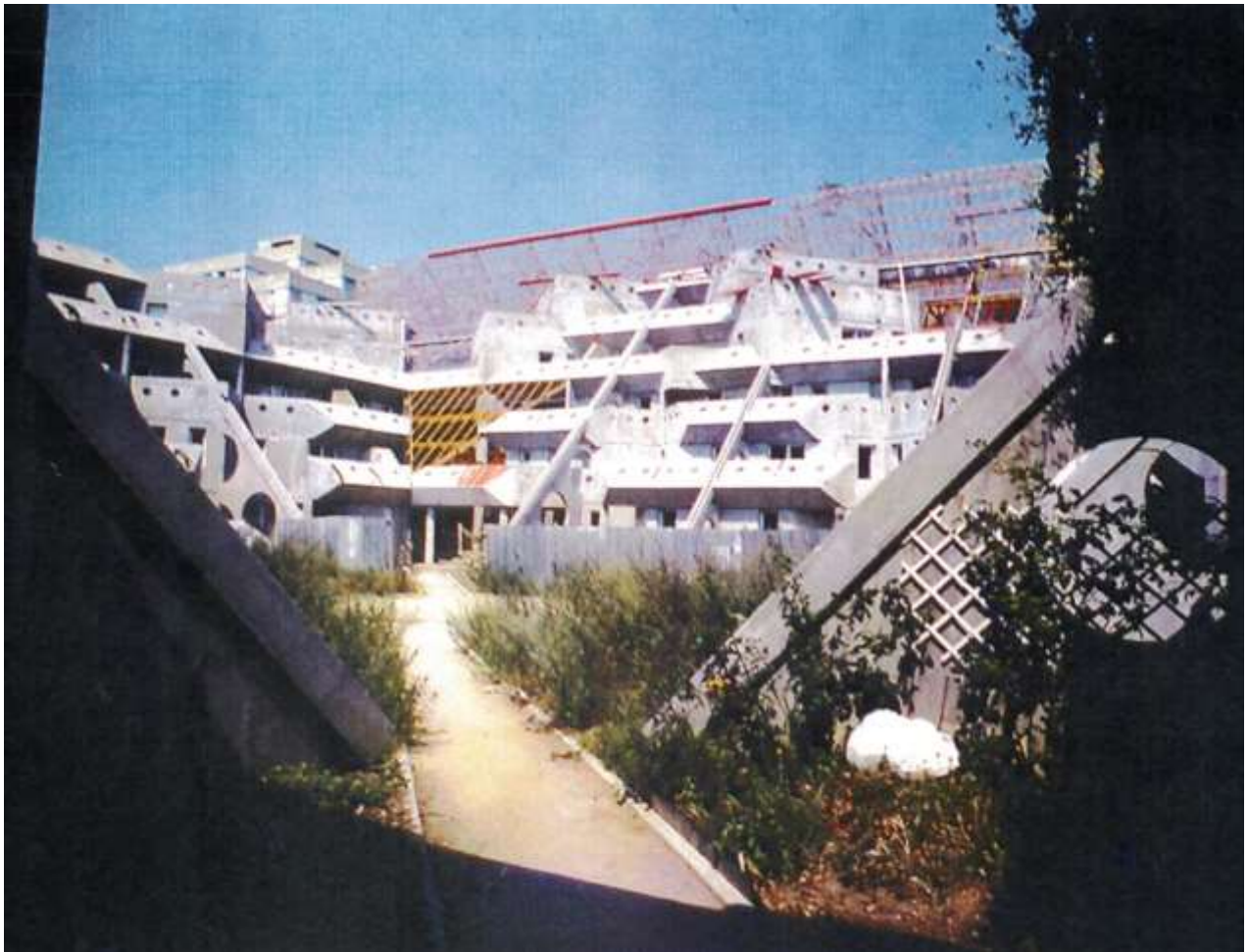
Le chantier de la ZAC du Barrage, à Pierrefitte en 1985 1
