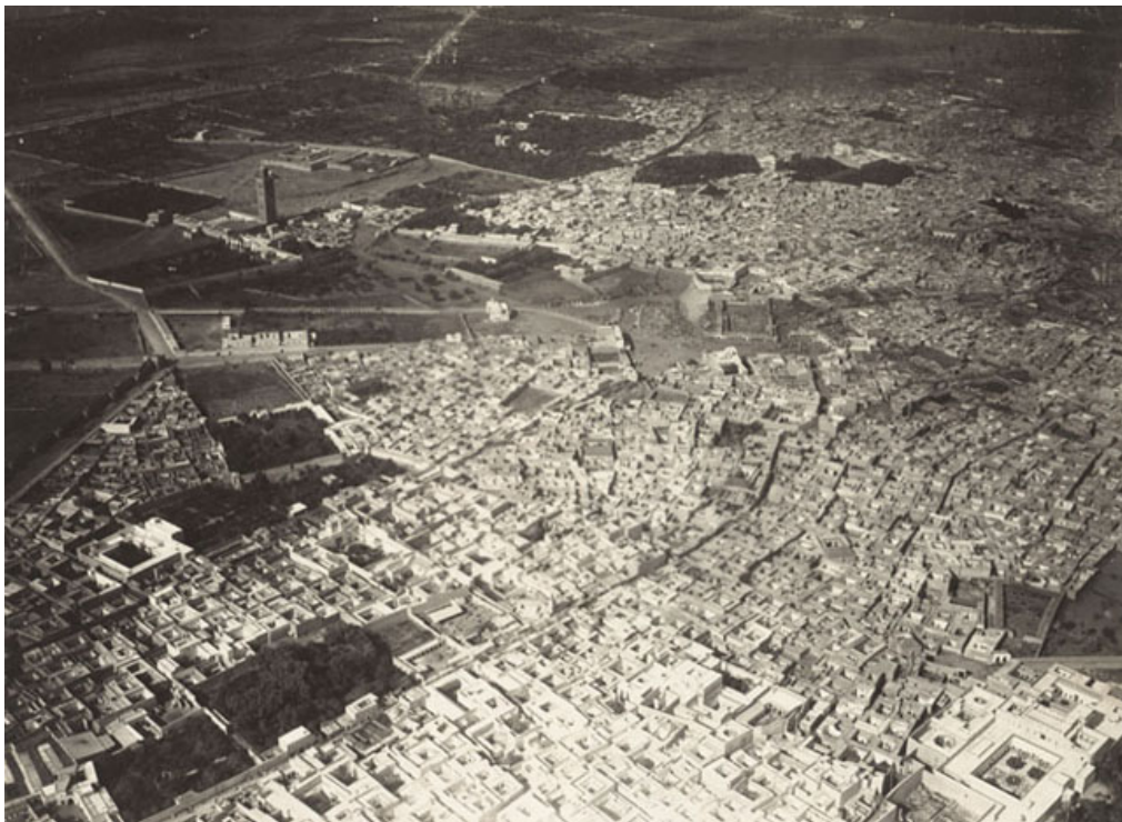
Figure 9 : Vue aérienne de la Médina de Marrakech (1916) montrant l'étroitesse des espaces réservés à la circulation publique par rapport aux maisons avec patios et/ou jardins clos, Marcelin Flandrin, circa 1916,
