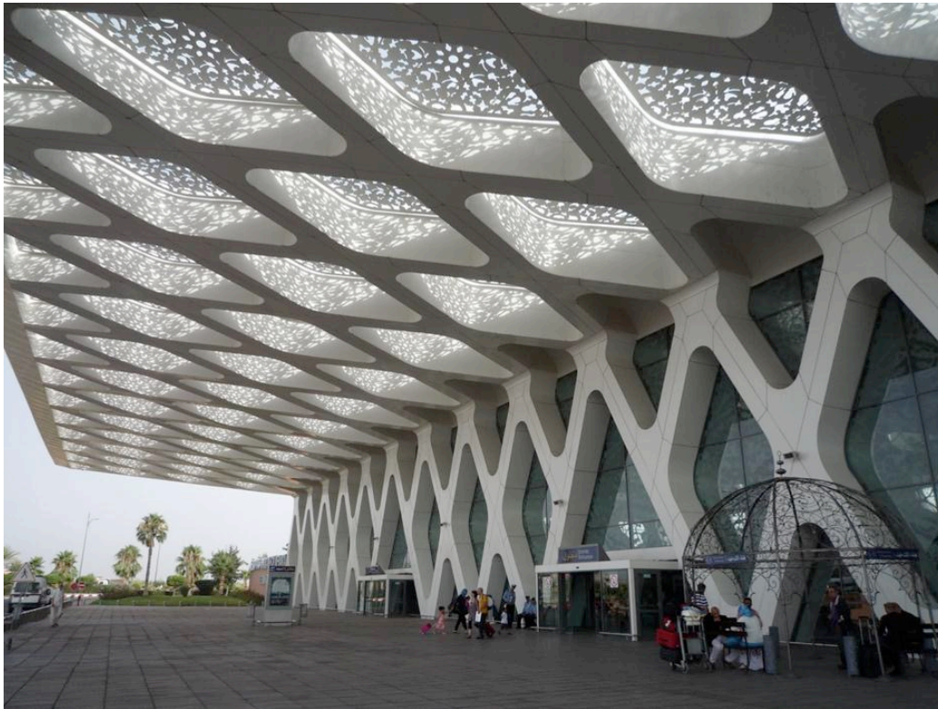
Figure 34 : L'entrée du nouveau terminal 1 de l'aéroport de Marrakech. 2009.
