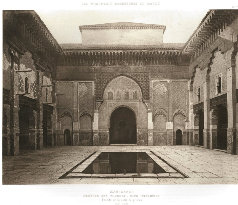
Figure 15 : Cour intérieure de la Medersa Ben Youssef probablement inspirée du modèle andalou.
