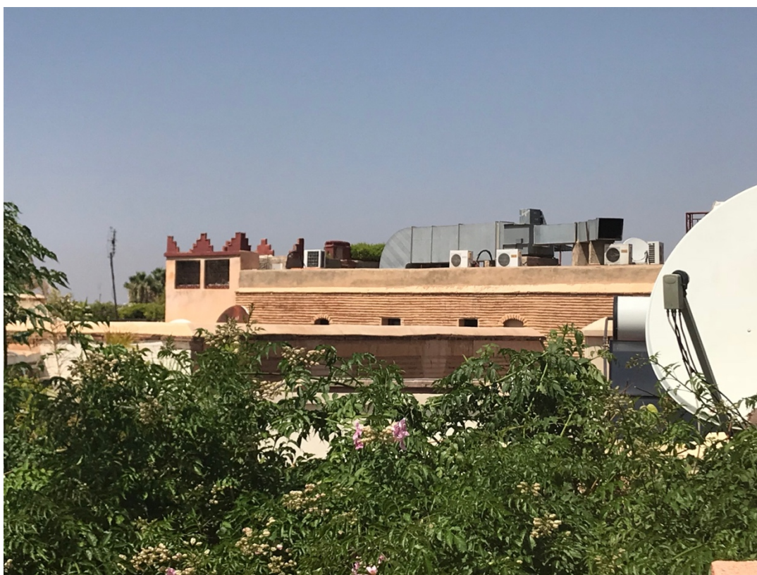
Figure 83 : photo prise chez notre interviewé à Qaat Benahid où on voit la terrasse surélevée d'un RMH voisin. Septembre 2018.
