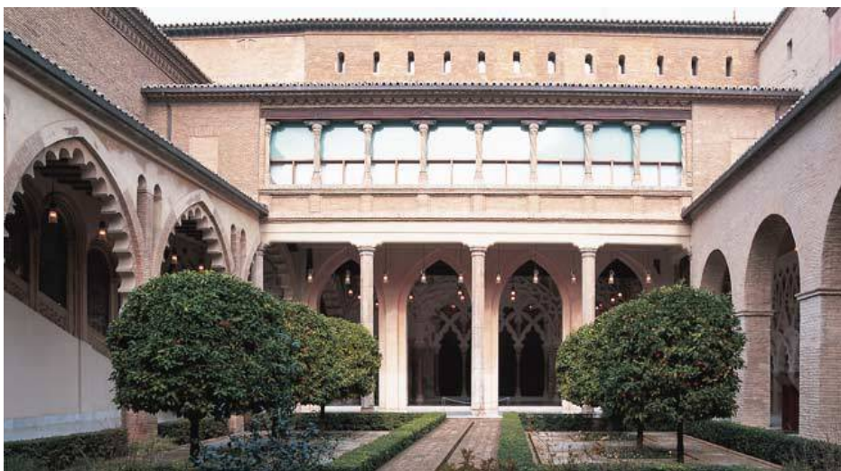
Figure 17 : Palais l'Aljafería de Saragosse avec jardin clos de plan cruciforme, 2017. Source : http://www.spainisculture.com (consulté en juillet 2018).
