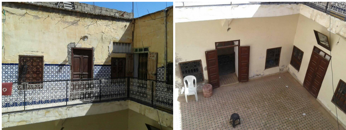
Figure 64 : Une maison au quartier Bab aylane transformée en maison de locataires où chaque pièce est habitée par une famille différente (à gauche : étage, à droite : rez-de-chaussée), 2018.
