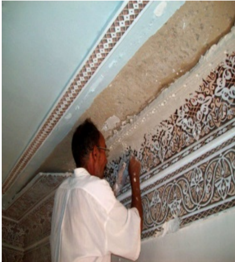
Figure 22 : Rénovation d'un toit en plâtre peint. Benaddi, 2017
