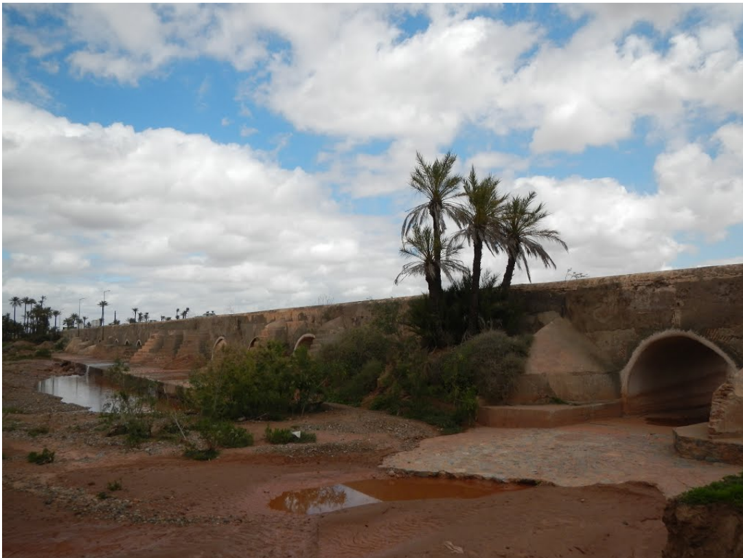
Figure 13b : Pont de Tensift aujourd'hui, 2018. Source : mapio.net/place/10741782 (consulté le 10 juin 2019).
