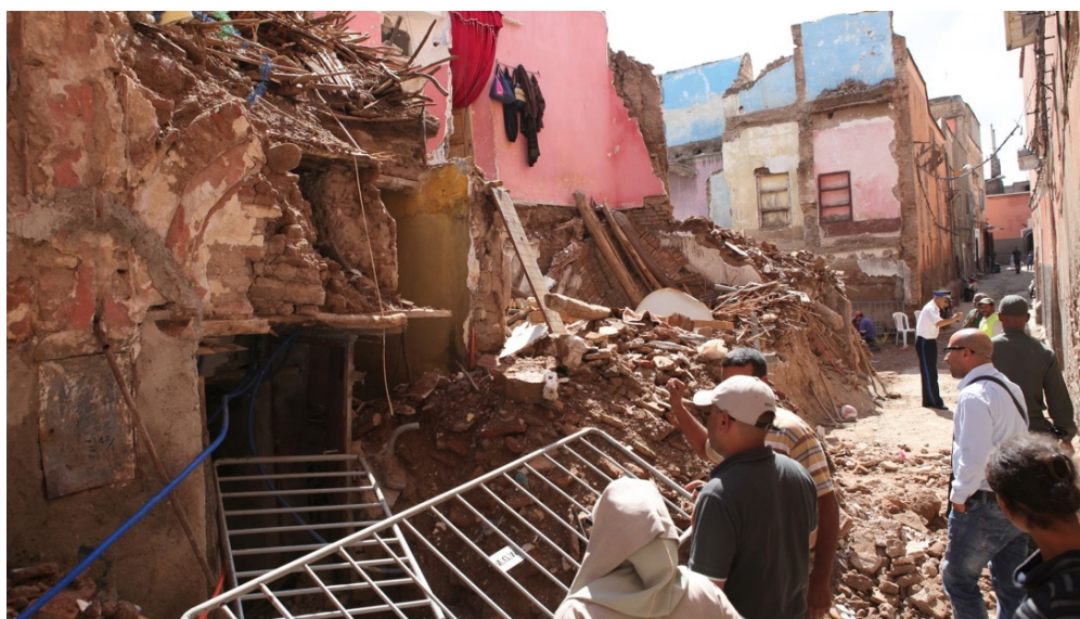
Figure 62 : Effondrement de plusieurs maisons traditionnelles à Derb Saba au quartier Al Mallah, 2013. (Akhmisse, 2013) 200
