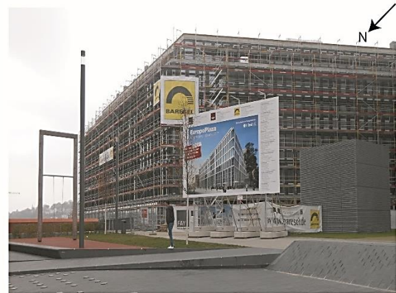
Construction de l'Europe Plaza Vue depuis la Place de Milan
