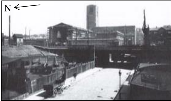
Photo 3 : Vue sur la construction de la gare Source : Dostal et Estler, 2012, p.14
