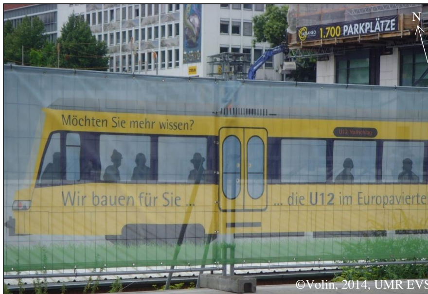
« Vous voudriez en savoir plus ? Nous construisons pour vous le métro U12 dans le quartier Europe » Photo 17 : Travaux dans le quartier Europe pour la construction d'une nouvelle station de métro
