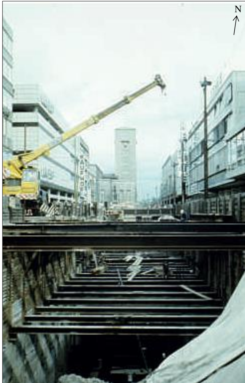
Figure 15 : Travaux de construction du métro durant la décennie 1970 Vue sur la Königstrasse Source : Müller, 2012 266
