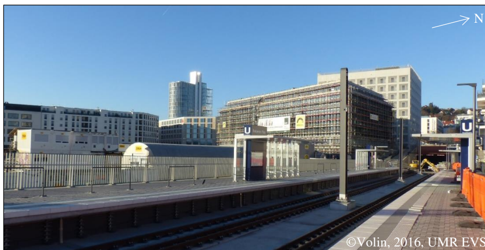
Photo 18 : Nouvelle station de métro, Budapester Platz
