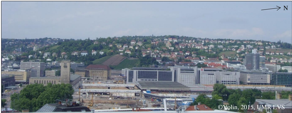
Photo 13 : Vue sur les travaux de la gare (bâtiment amputé de ses deux ailes), depuis la colline d'Ostheim, Haussmannstrasse
