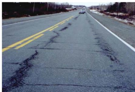
Figure 1-34. La fissuration s'accroît et d'autres fissures apparaissent en surface (MTQ, 2008)
