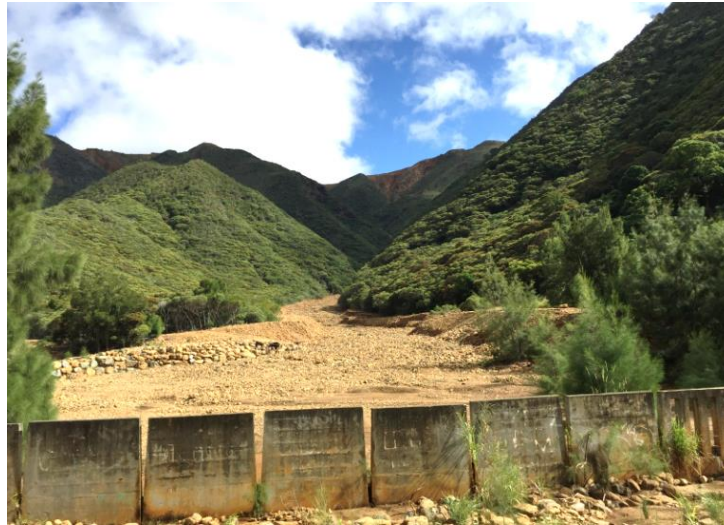
Figure 6 : Vue d'un aménagement (peigne) visant à réduire l'apport de sédiments grossiers sur le bassin versant de Thio (Source : O. Evrard)
