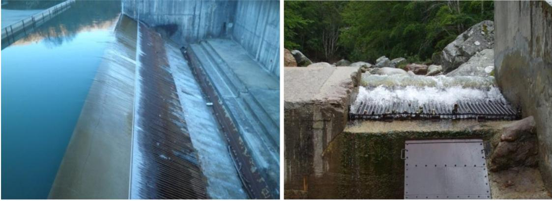
FIGURE 4.18 – Exemple d’une prise d’eau tyrolienne classique: Saint Marcel sur le Doron de la rivière de Belleville (d’altitude 1437 m) (à gauche) et Bocognano sur la rivière du Gravone (d’altitude 890 m) (à droite) – France (Dewitte et David, 2018).
