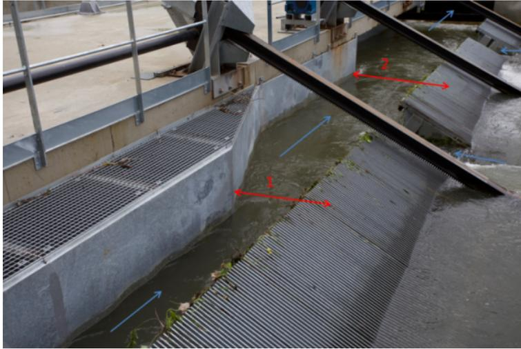
FIGURE 2.13 – Positionnement des jaugages réalisés dans la goulotte de Las Rives.
