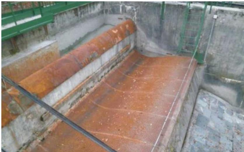
FIGURE 4.17 – Diagramme de la prise d'eau Lépine (en haut) et exemple de la prise d'eau Brides les Bains (d'altitude 695 m) sur la rivière du Doron des Allues – France (en bas et sans eau) (Dewitte et David, 2018).
