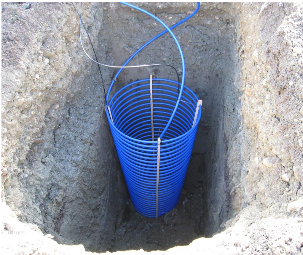
Figure 1. Photographie d'une corbeille géothermique en cours d'installation (Moch, 2013). Cette corbeille géothermique RWB-Terra a été installée sur le site de Technolac (Le Bourget-du-Lac, France). La base de la corbeille est à une profondeur d'environ 3.5 m. Son diamètre et sa hauteur sont respectivement de 1.0 m et de 2.4 m.
