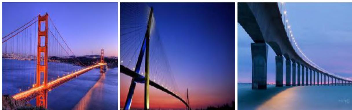
(a) Le Golden Gate Bridge (pont suspendu) (b) Pont Normandie (pont à haubans) (c) Pont de l'île de Ré (en béton précontraint)
